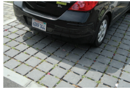
3 Дождевая вода уходит через специальное покрытие проезжей части, клумбы и специальные поверхности, пропускающие воду.
